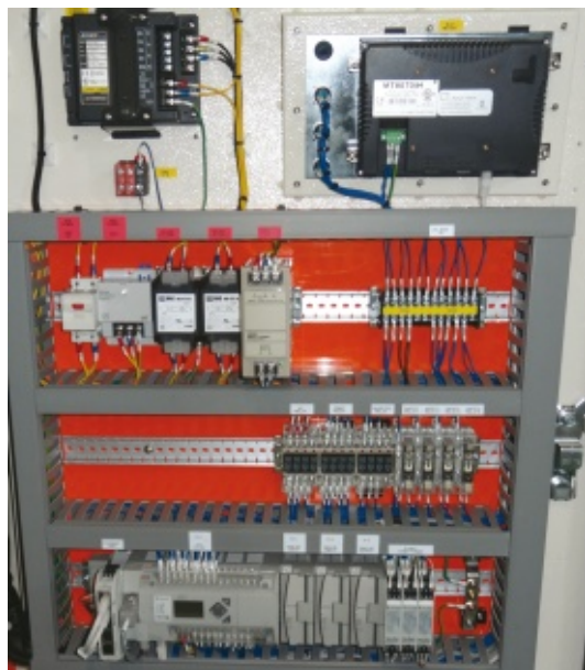
Przykładowy Sterownik PLC wraz z oprzyrządowaniem i panelem dotykowym zabudowany w dmuchawie.
