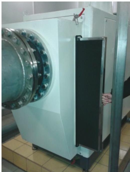
Łatwa wymiana filtra głównego.
