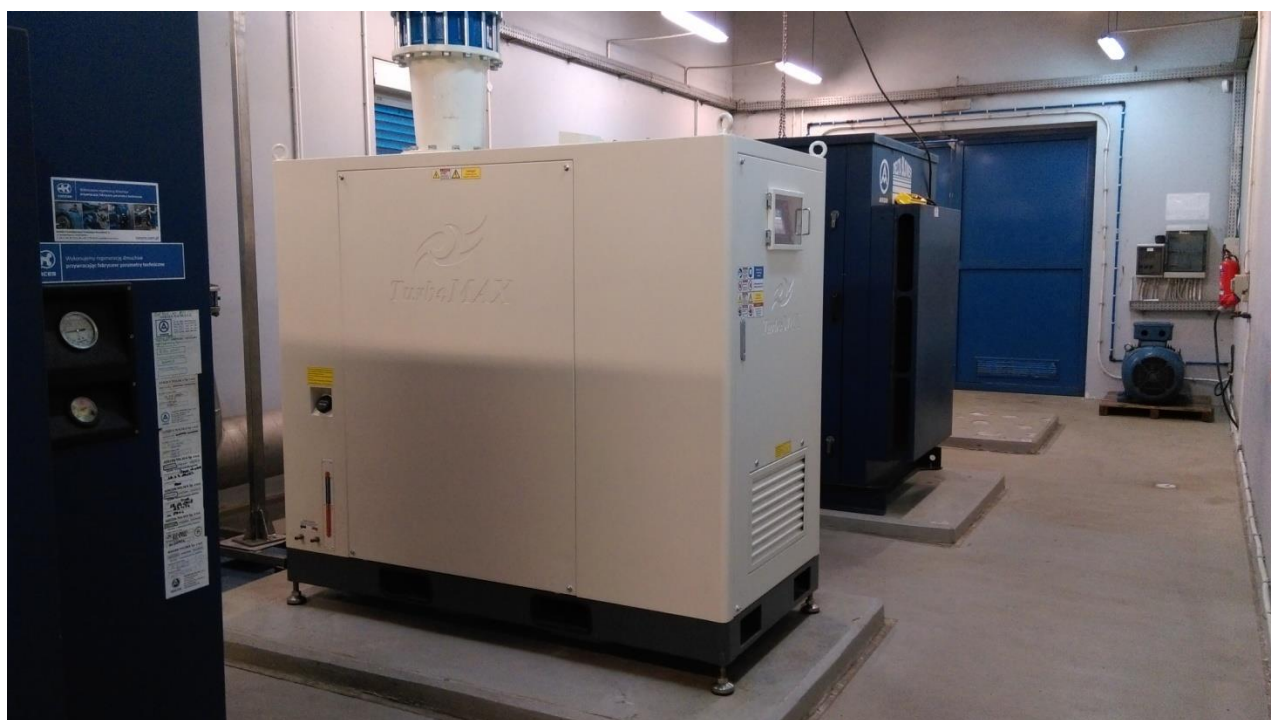
Rys.2 O.Ś. Szczecin „Zdroje” – dmuchawa MAX250
