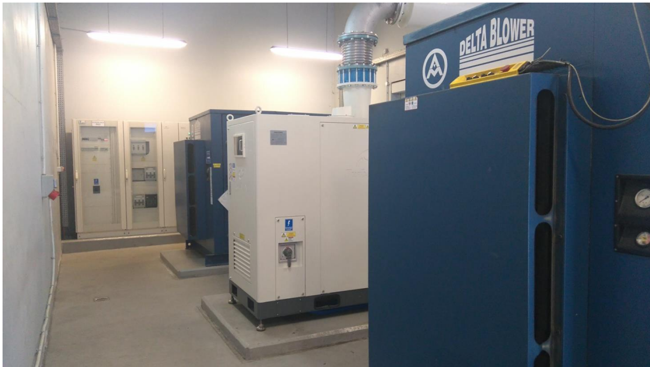
Rys.1 O.Ś. Szczecin „Zdroje” – dmuchawa MAX250
