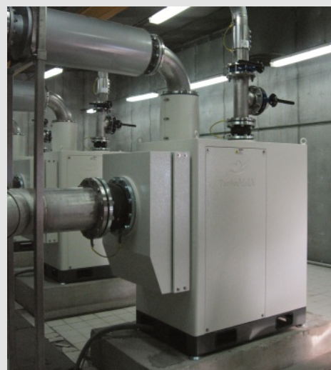
Wersja obudowy z kołnierzem do przyłączenia rurociągu po stronie ssącej.
