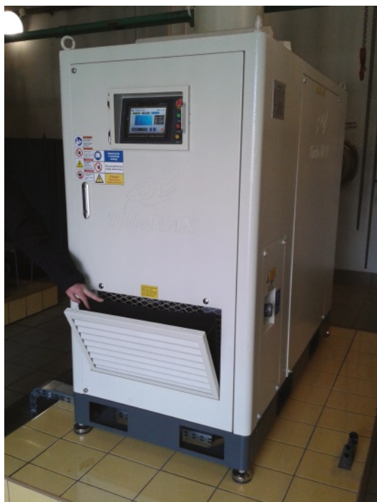
Łatwa wymiana filtra przedziału elektrycznego.
