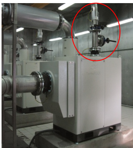
Opcjonalne orurowanie do wyprowadzenia ogrzanego powietrza z układu chłodzenia silnika na zewnątrz pomieszczenia z przełącznikiem (system dwóch przepustnic ręcznych) zima-lato.
