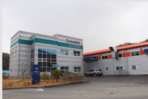
Biuro konstrukcyjno-projektowe oraz stacja testowo-badawcza.
