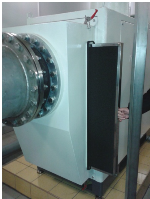
Łatwa wymiana filtra głównego.
