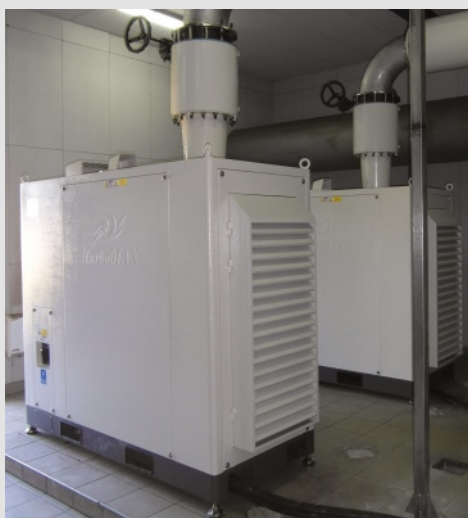
Wersja obudowy z żaluzją wlotową.
