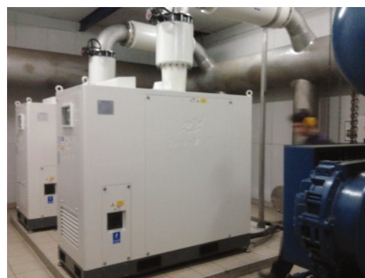
2013 r. O.Ś. Bielsko-Biała - Komorowice, stacja dmuchaw nr 2 dmuchawy: 2 szt. MAX250
