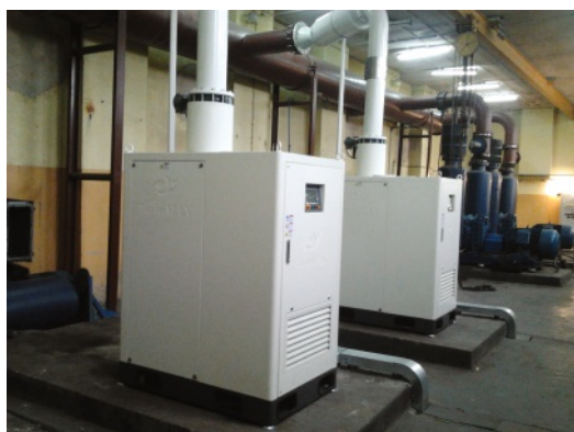
2011 r. O.Ś. Bielsko-Biała - Komorowice, stacja dmuchaw nr 1 dmuchawy: 2 szt. MAX75
